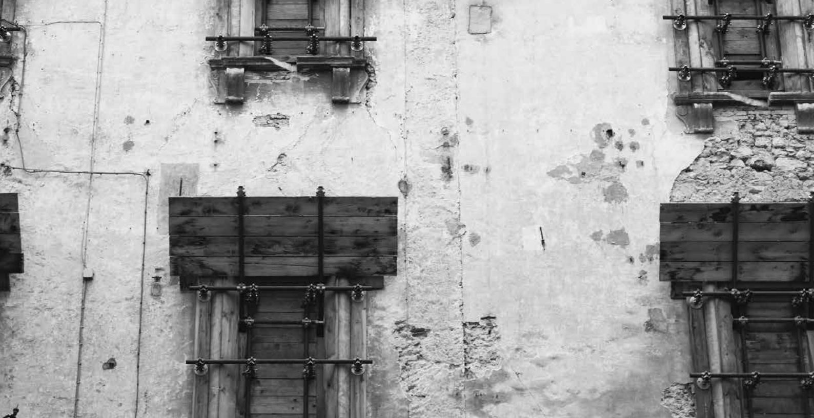
Facciata di un palazzo privato messo in sicurezza (foto di S.F.). Nella pagina accanto: statua e gru in Piazza Duomo (foto di E.Z.)
