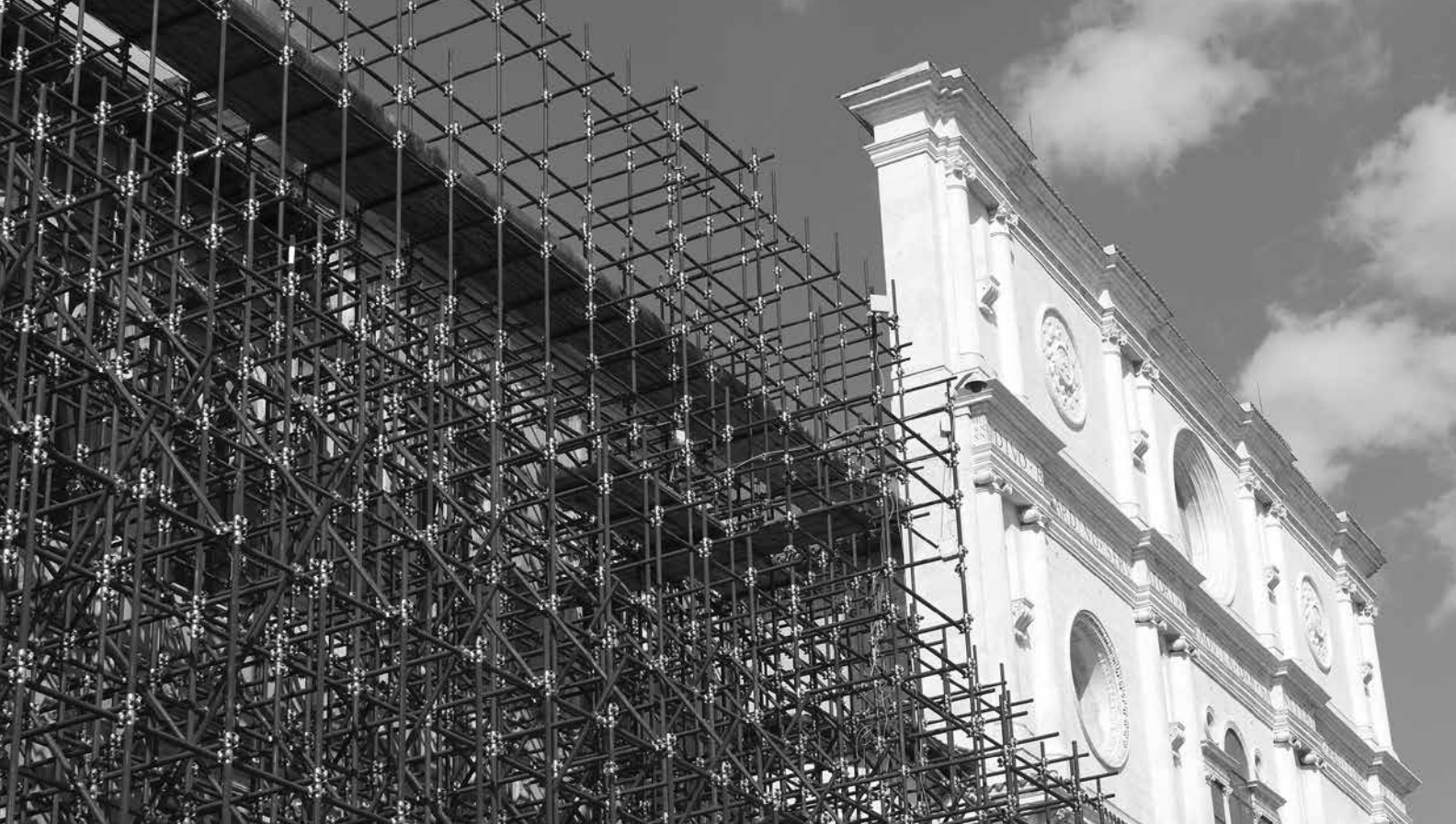
Facciata della Scuola De Amicis interamente puntellata e San Bernardino
