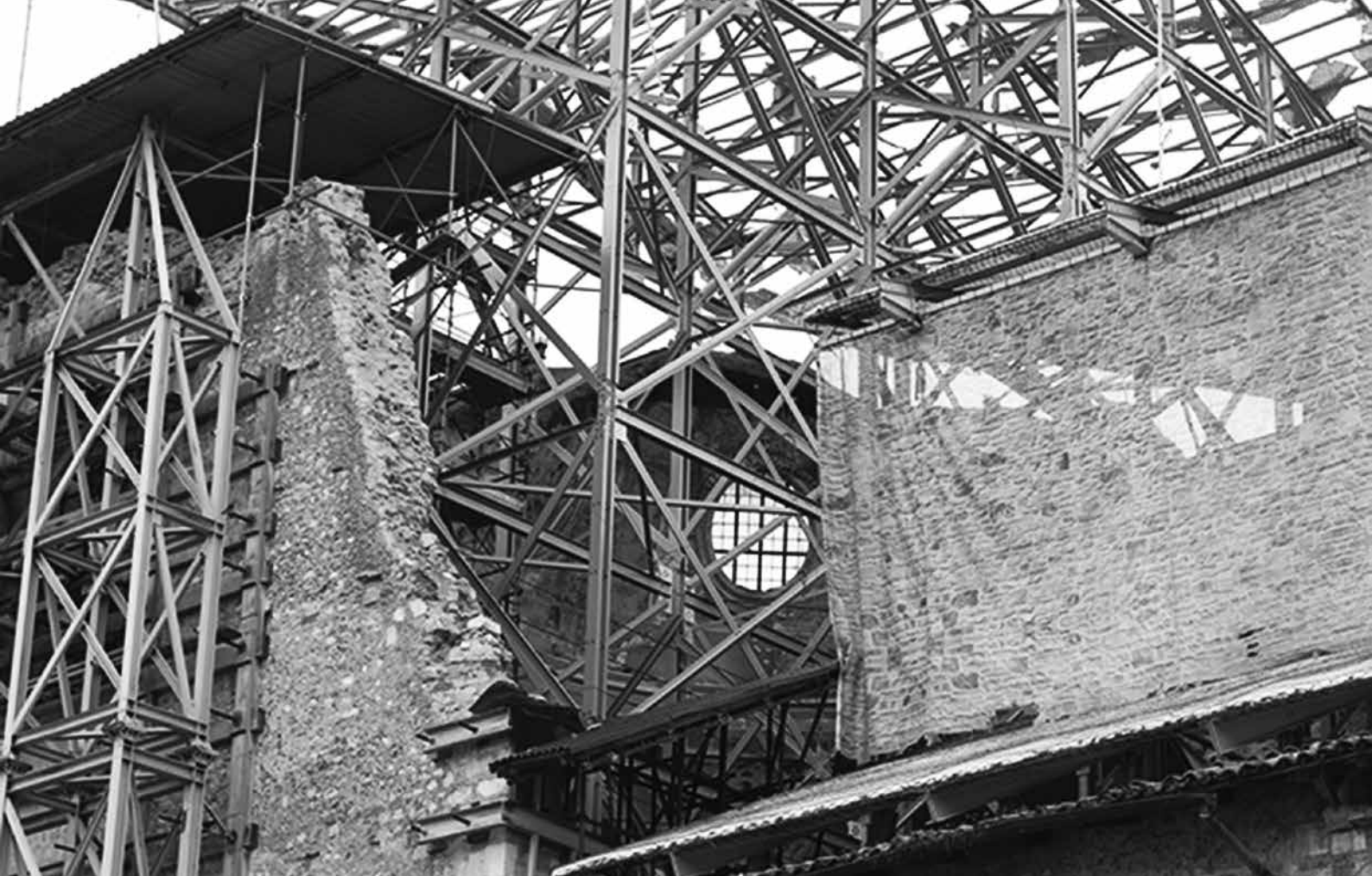
Copertura di Santa Maria Paganica oggi; dopo la messa in sicurezza nei mesi seguenti il sisma, non è stato aperto alcun cantiere (foto di E.Z.)
